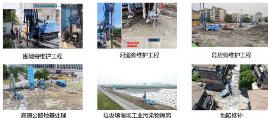
图注 17：不同场景的地下维修维护工程
