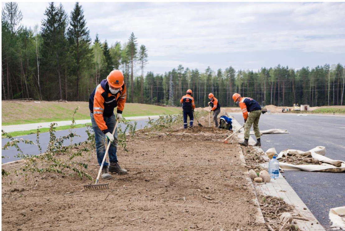
身着公司工服的当地分包人员正在进行绿植施工
