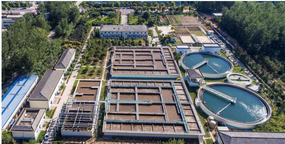
邳州污水处理厂全景图
