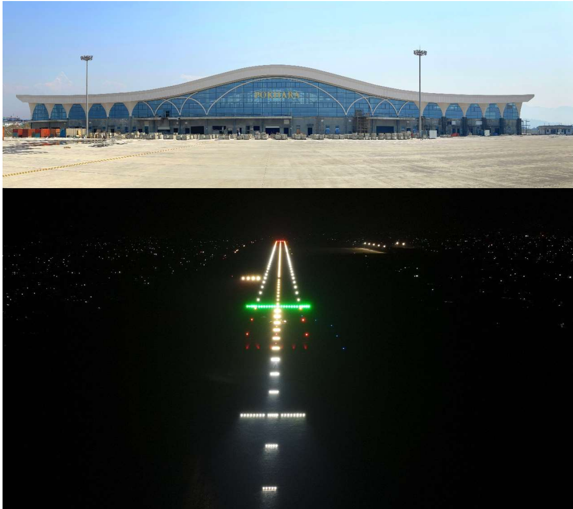
尼泊尔博卡拉机场项目
