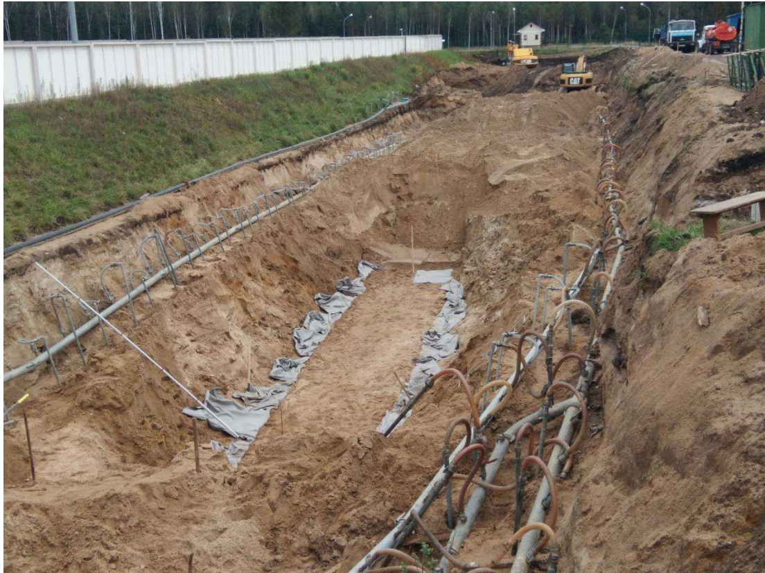
当地分包商正在进行基坑降水
