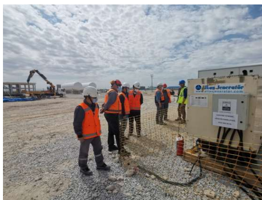
项目部开展安全大检查
