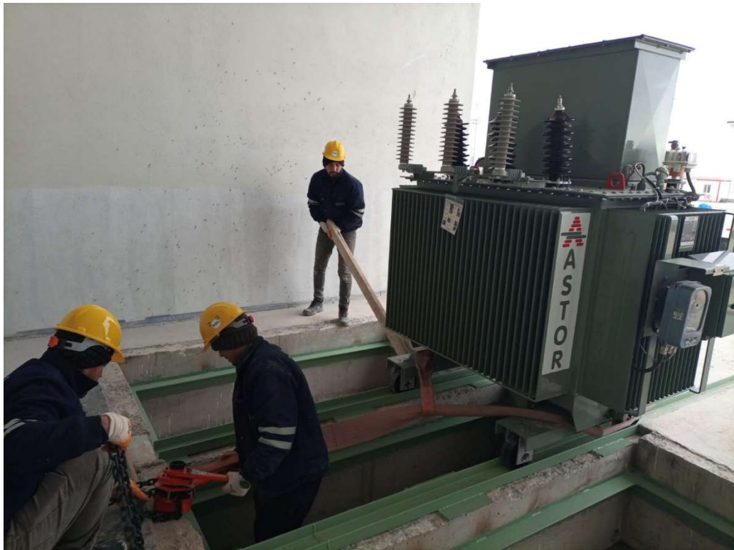
当地分包商正在安装变压器
