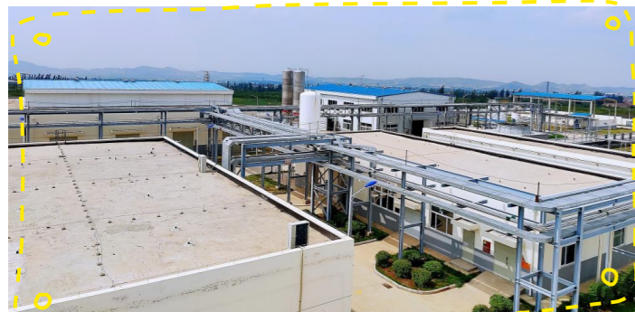
张家口氢能产业化应用示范园建设项目
