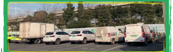
上海昆仑新奥充电站
