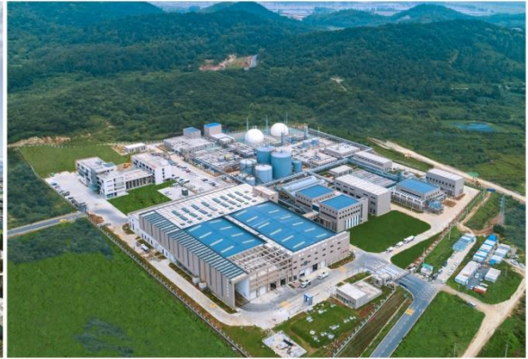
南京江北废弃物综合处置中心
