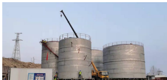
建设中的济源恒通 12 万吨生物降解塑料 (PBAT) 项目
