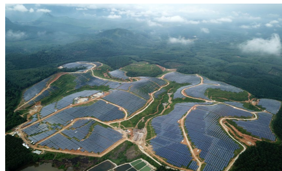
马来西亚 62MWp 光伏电站项目
