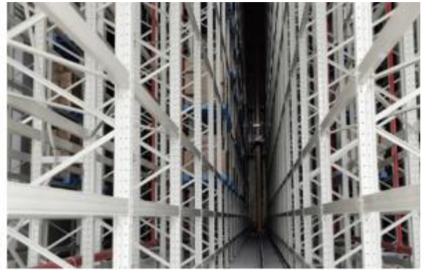
智能立体仓储系统
