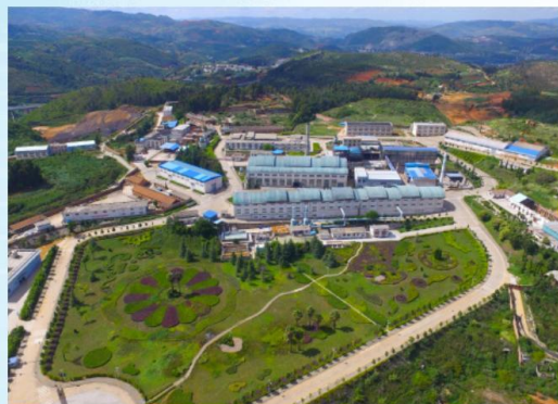
绿色工厂——云锡锡化工有机锡生产厂区
