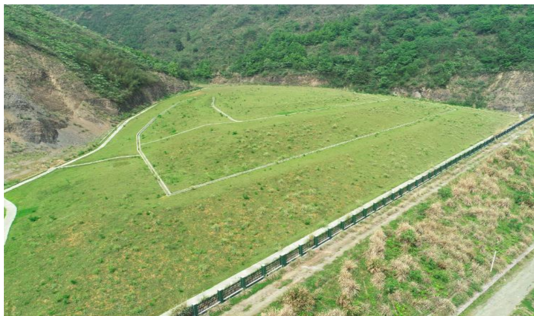
石门县雄黄矿区含砷矿渣综合治理工程（三期）
