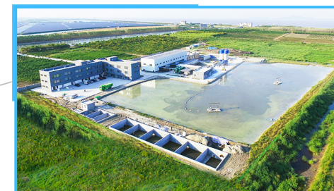
绍兴柯桥循环经济园地块淤泥处理项目
