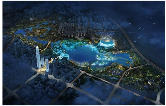
大运会主会场东安湖片区基础设施建设项目
