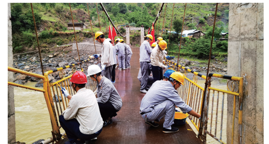
深能水电帮助修复格洼村吊桥
