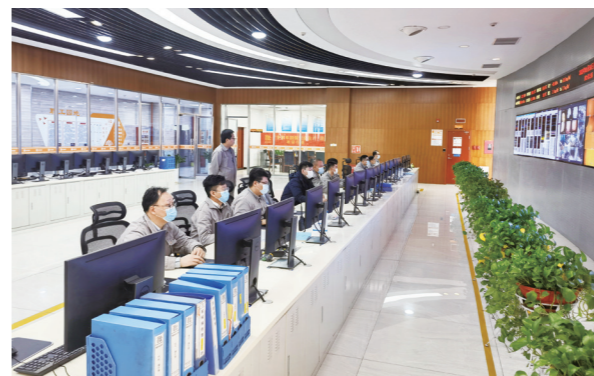
保定电厂加强机组运行监盘
