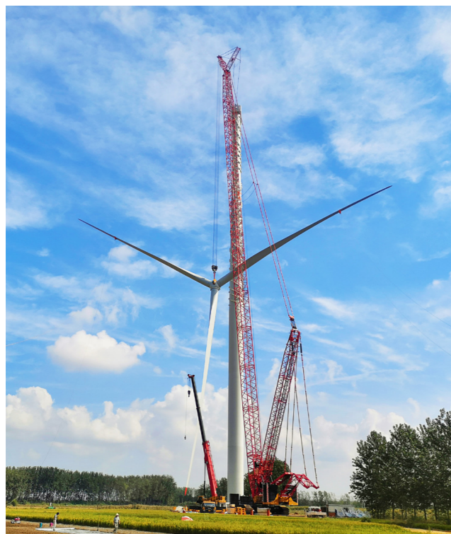
加强施工项目安全管理
