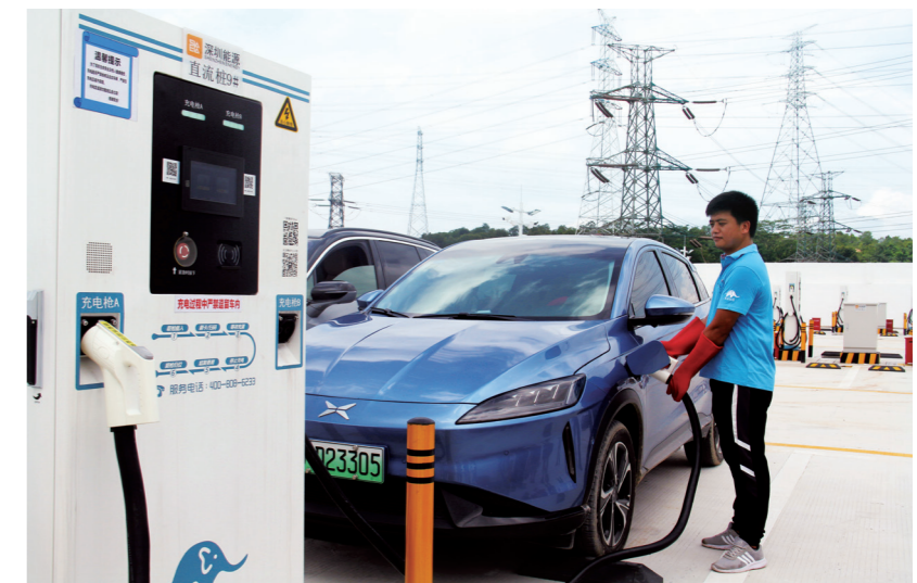
智慧能源充电站
