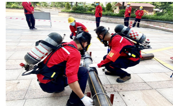
深能燃控燃气管道抢修演练
