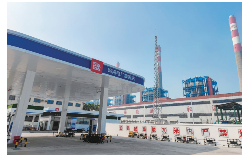
妈湾电厂加氢站
