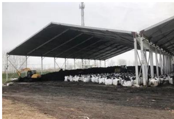
(土壤修复项目)
