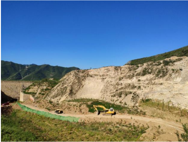
▲中节能铁汉采用高分子有机纤维丝补强土植生修复技术修复冬奥廊道沿线 (左图为修复前，右图为修复中)
