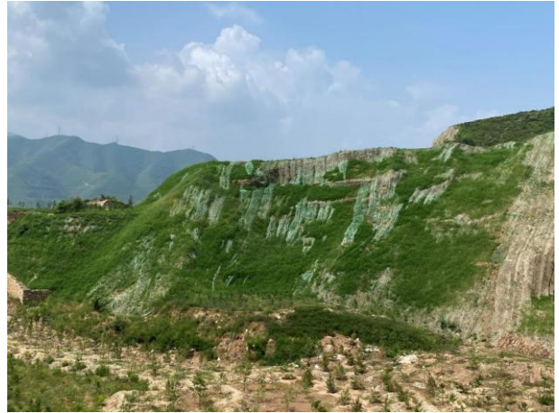
▲中节能铁汉采用高分子有机纤维丝补强土植生修复技术修复冬奥廊道沿线 (左图为修复前，右图为修复中)
