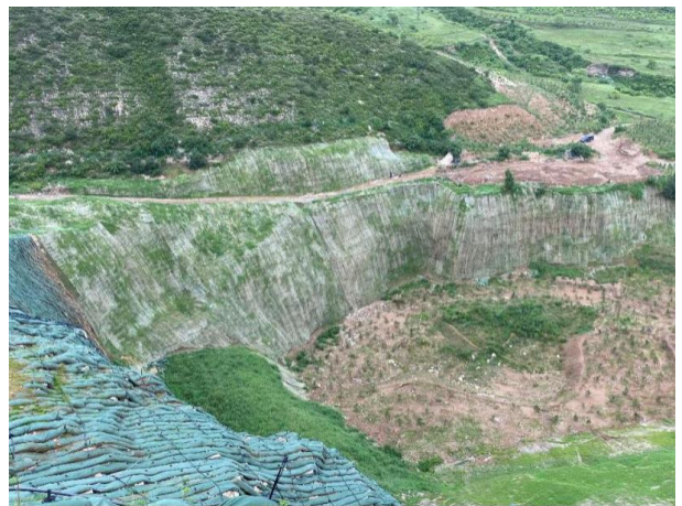
▲中节能铁汉采用高分子有机纤维丝补强土植生修复技术修复冬奥廊道沿线 (左图为修复前，右图为修复中)
