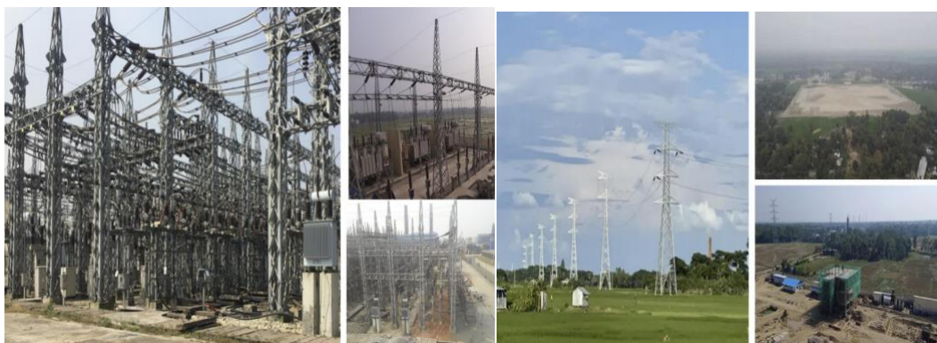
图 7：孟加拉 400/230KV GIS 变电站项目 图 8：孟加拉国家电网升级改造项目
