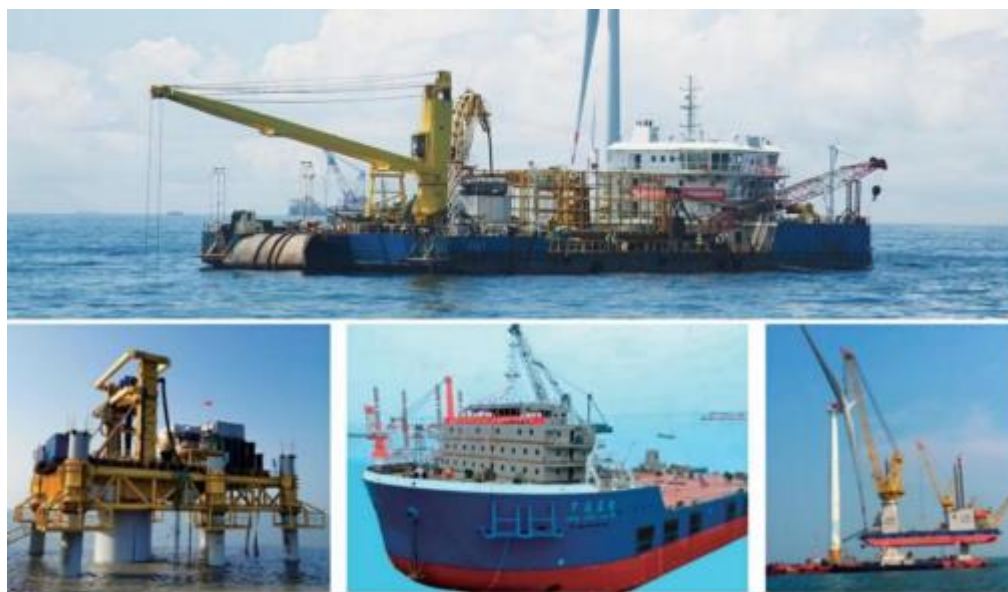
图9 部分海上施工船（敷缆、嵌岩、吊装等）
