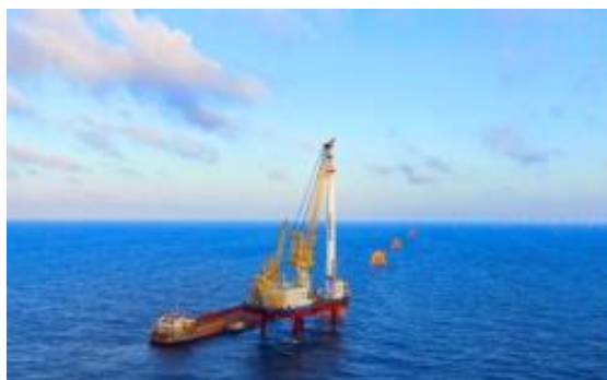
图 3 “华电稳强”号海上风电作业平台
