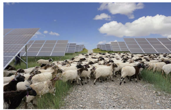
河北围场光伏电站开展“借羊除草”行动
