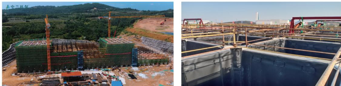
中兰环保承建的青岛铁山填埋库 1A 区防渗项目由 370 个 4 m x 4 m x 15.6 m 小填埋单元组成，是目前国内最深的刚性防渗单元。同时，为确保防渗效果，项目在常规刚性防渗结构基础上增加了防水卷材，确保零渗漏风险，从源头杜绝危险废物污染环境。项目的实施，补充了刚性防渗填埋单元的结构多样化。
