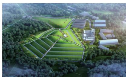
中兰环保承建的岳阳市八字门垃圾填埋场项目是简易垃圾堆放场，未设置防渗、渗滤液和填埋气的导排、处理等设施。填埋场治理前存在甲烷排放超标、重金属污染土壤、堆体稳定性差等问题。该项目采用原位封场治理工艺，项目封场面积 4.5 万平方米，垃圾治理量 57.2 万立方米，项目的实施改善了填埋场周边环境，降低“邻避效应”，杜绝垃圾填埋产生的二次污染。
