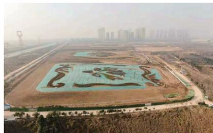
中兰环保承建的西安市高陵区生活垃圾卫生填埋场是目前高陵区仅有的一座生活垃圾卫生填埋场，占地约 101.44 亩，累计填埋垃圾约 50 万立方米。治理前现场存在堆体内渗滤液含量高、填埋场超负荷运营、堆体滑坡、垃圾坝溃坝、气体对空排放等问题。本项目的实施彻底解决了填埋场环境污染问题，对提升城市良好形象、环境保护和生态修复、落实国家规范及标准发挥了重要的作用。
