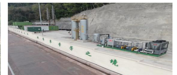
中兰环保运营管理的重庆市铜梁区太平生活垃圾填埋场是国内首个填埋场市场化运营服务和填埋气发电BOO项目协同运行的项目：填埋场运营 - 日处理规模约500吨，应用中兰环保首创的“四色法”、“五全法”进行生态型填埋场的运营，高效收集及利用填埋气，促进节能减排 / 填埋气发电 - 预计每小时可产生大于1000立方米的填埋气，每年产生1600万度电，可供16000户家庭用电，实现16000吨温室气体减排。
