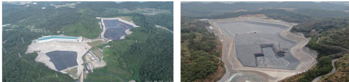
深圳市东部环保电厂是全球最大的焚烧发电厂之一，中兰环保承建该项目配套的灰渣综合利用及处置场防渗项目。项目占地面积 27.68 万平方米，炉渣填埋区总库容约 162 万立方米，飞灰填埋库区总库容为 248 万立方米。项目采用双层防渗系统，总体使用年限 28 年以上，现已投入使用，有效解决固体废弃物末端处置需求，是生活垃圾处置的终端保障工程。
