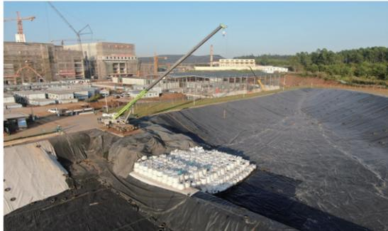
中兰环保运营的中电国际海口环保飞灰稳定化物填埋及填埋场运维项目主要内容为飞灰稳定化物填埋、填埋场调试配合和填埋场运行维护。飞灰填埋场的库容29万立方米，飞灰稳定化物最大填埋量约145吨/天，年填埋量约3.5万吨。飞灰填埋规划按月、周进行详细设计，通过规范填埋作业在运维过程中坚决阻隔雨水进入堆体，确保渗滤液“零”产生，避免环境污染事故发生。
