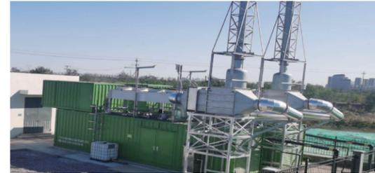
中兰环保投资建设的天津市大韩庄填埋气发电扩容项目建设装机容量为2MW，于2020年10月建成投产。2021年，项目发电量为1141.18万度，实现1.14万吨二氧化碳减排，折合节约标准煤约0.37万吨。
