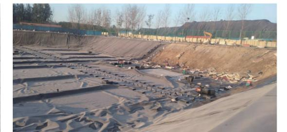
受郑州特大暴雨“7.20”的影响，郑州市垃圾综合处理厂渗滤液调节池原浮盖膜损毁严重，中兰环保充分发挥技术人才和管理优势，快速响应，高质量完成了覆盖膜修复工作，调节池覆盖膜重新恢复使用功能，有效阻止雨水进入池体。
