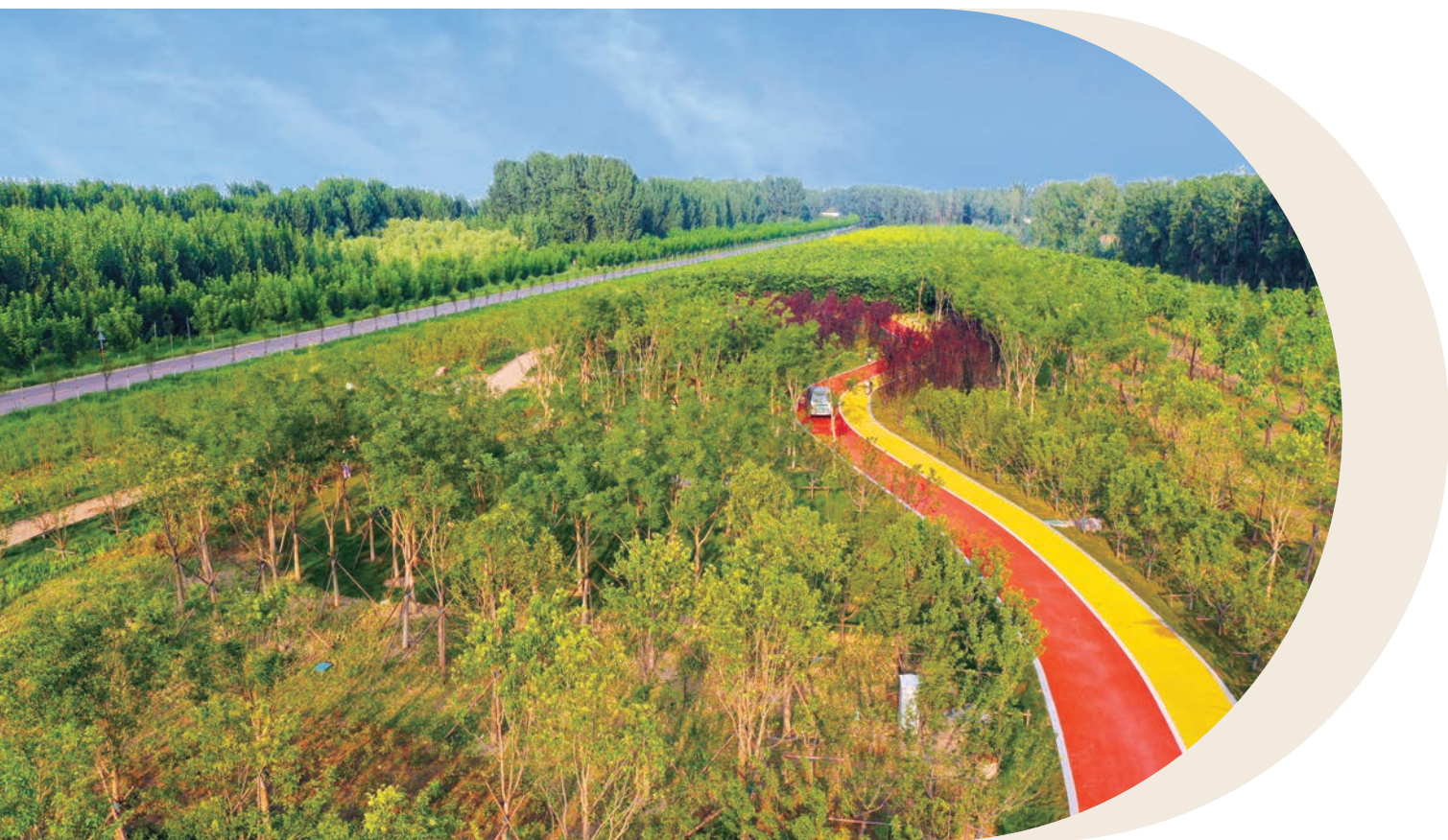
©河南开封黄河生态廊道示范带项目
