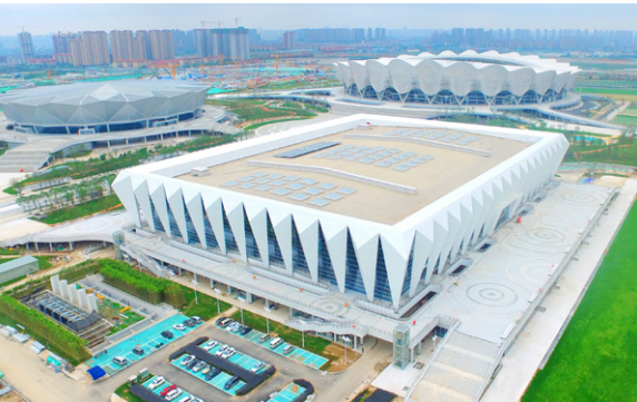
西安奥体中心游泳跳水馆项目荣获“鲁班奖”
