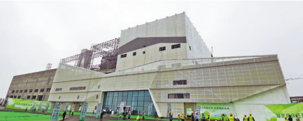
灞桥生活垃圾热电项目建成后，预计年处理生活垃圾 109.5 万吨，发电 4.256 亿度，年均供热量约 60 万吉焦
