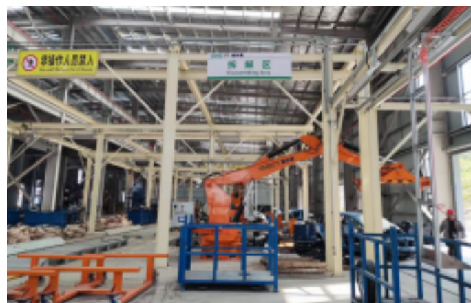
深汕园区报废汽车拆解产线
