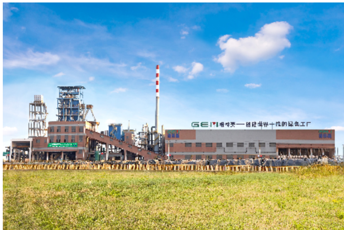
荆门废旧线路板热解产物及多金属固废资源综合利用产线
