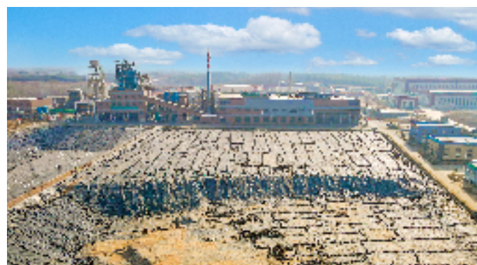
一般固废填埋场
