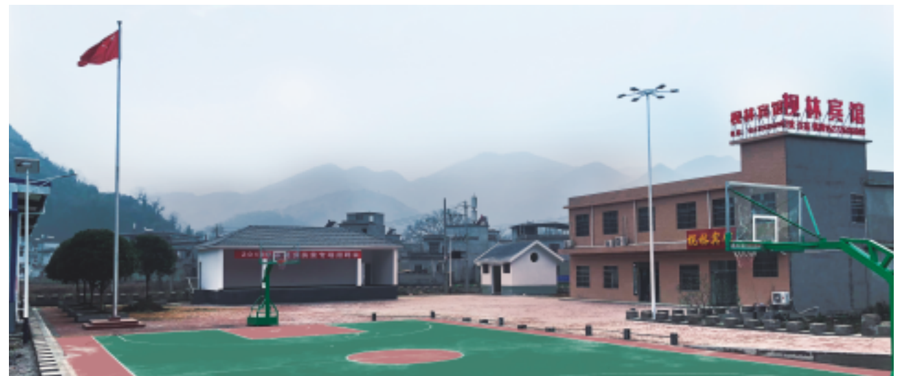
格林美对口帮扶咸宁市崇阳县高视村修建村级文化广场
