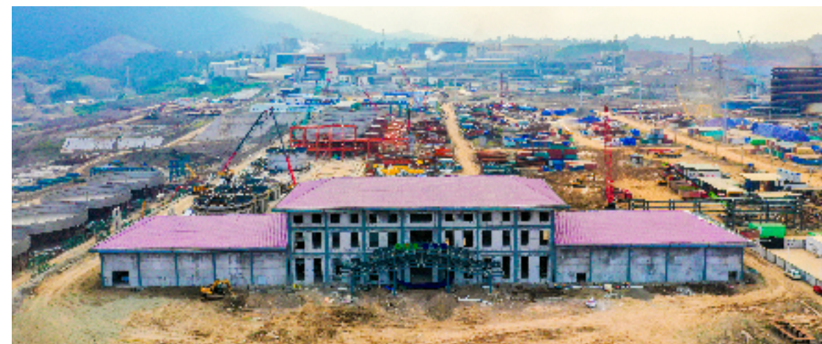
印尼项目如火如荼、日新月异的建设现场
