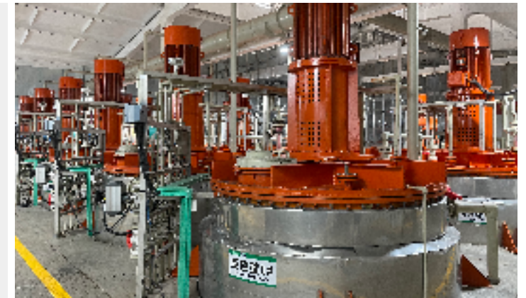
泰兴园区新建四氧化三钴产线
