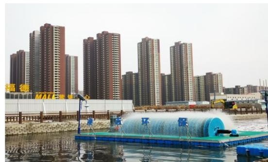
抚州孝义港项目转碟曝气机设备安装完成
