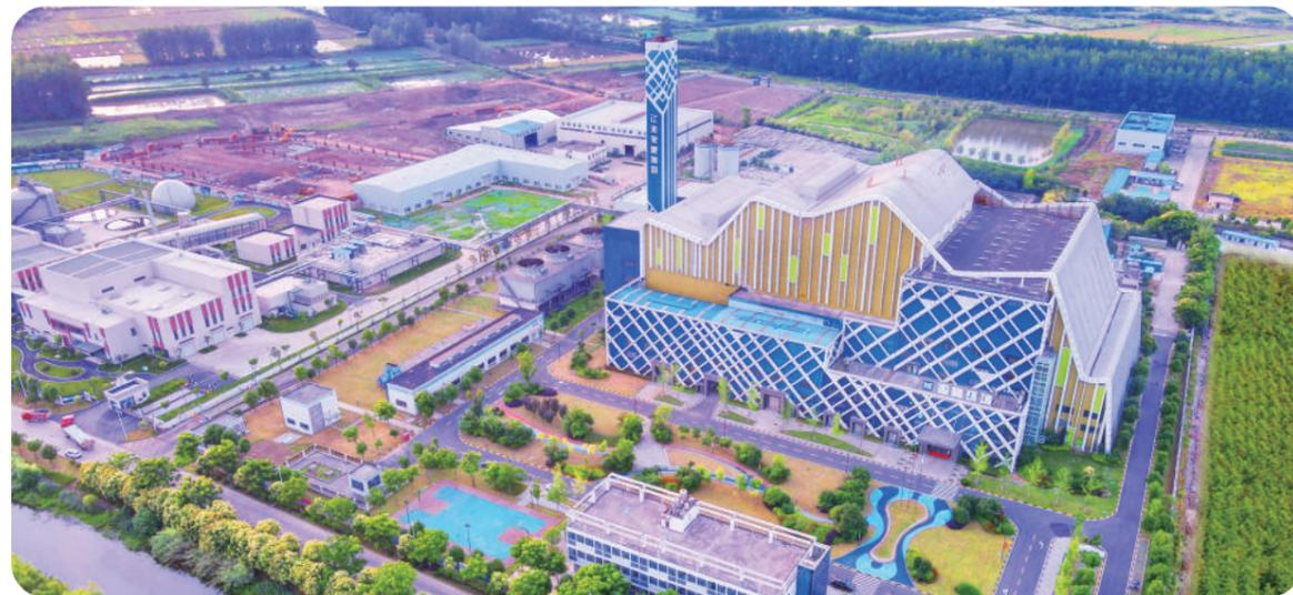
湖北省仙桃市生活垃圾焚烧发电厂，BOT特许经营期为30年，总投资约5.5亿元，规划日处理规模1000吨，1、2期分别规划日处理500吨，主要配置2台500吨/日倾斜往复逆推式炉排焚烧炉，1台9MW、1台10MW凝汽式汽轮发电机组。实现生活垃圾的“减量化、无害化、资源化”处理，是工业旅游基地、环保教育基地、市民活动基地。
