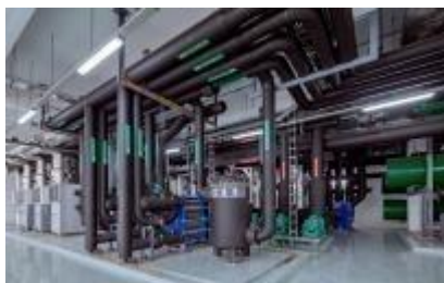
珠海方正PCB产业园
