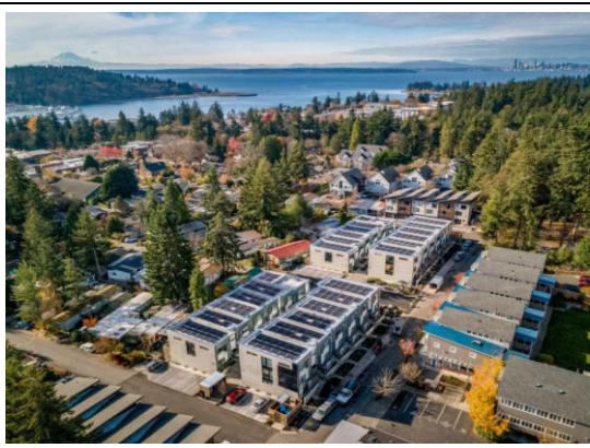
西雅图零碳社区 212.4kW 项目
