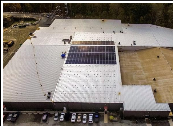
美国宾夕法尼亚州 808kW 工商业项目
