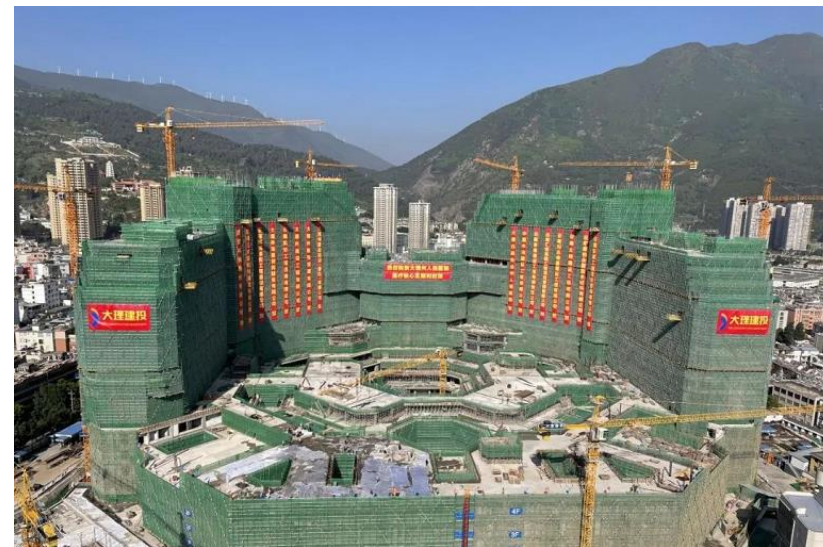
大理州人民医院医疗核心区建设项目主体结构顺利封顶
