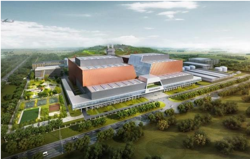
北京安定垃圾焚烧发电项目
