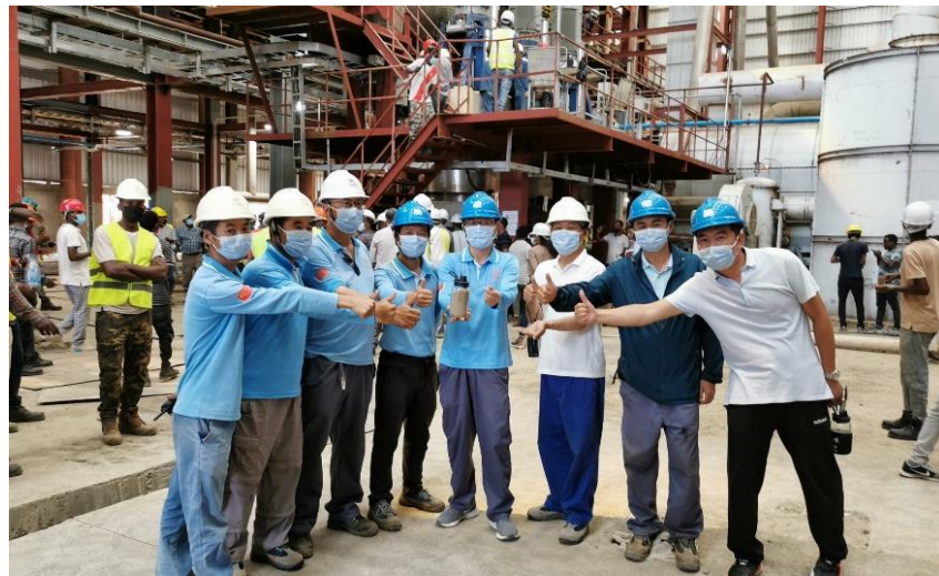
埃塞俄比亚BELES-1号糖厂续建项目顺利出糖
