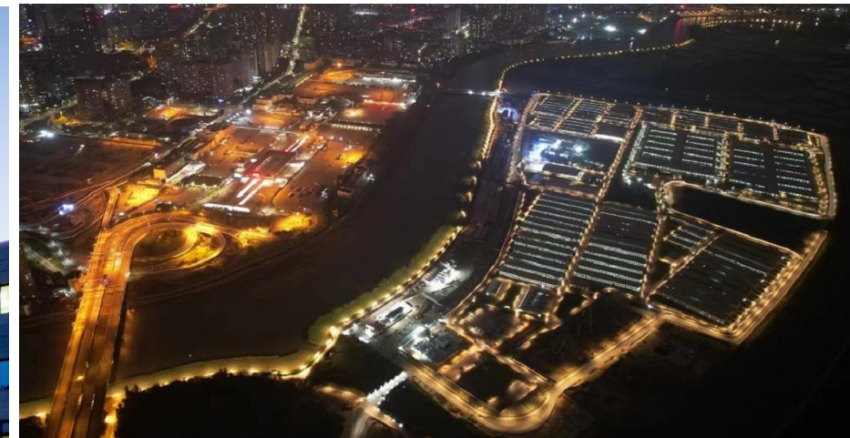
援港应急医疗设施建设项目设计顺利交付
