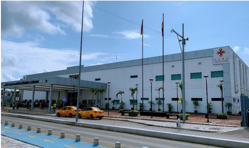
厄瓜多尔乔内医院通过验收并完成交接
