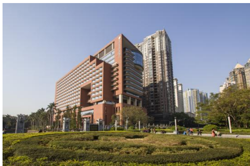
中山大学科技文化交流中心装修工程 (中国建筑工程装饰奖)
