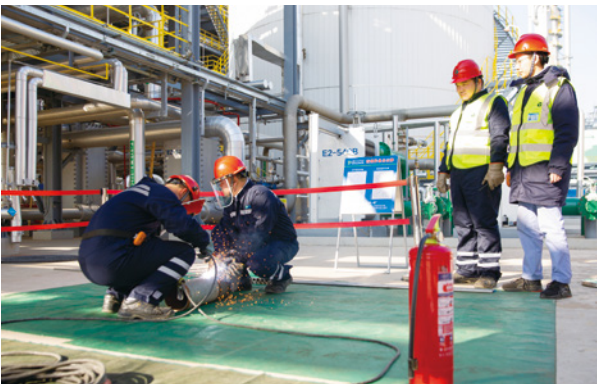
动火作业旁站式管理现场
