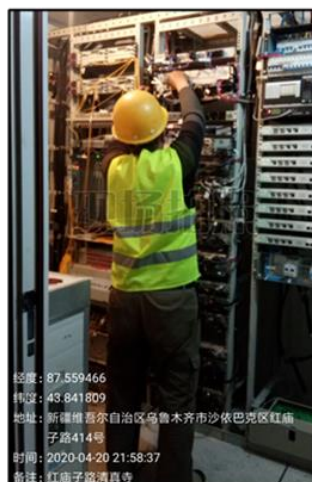
基站设备安装
