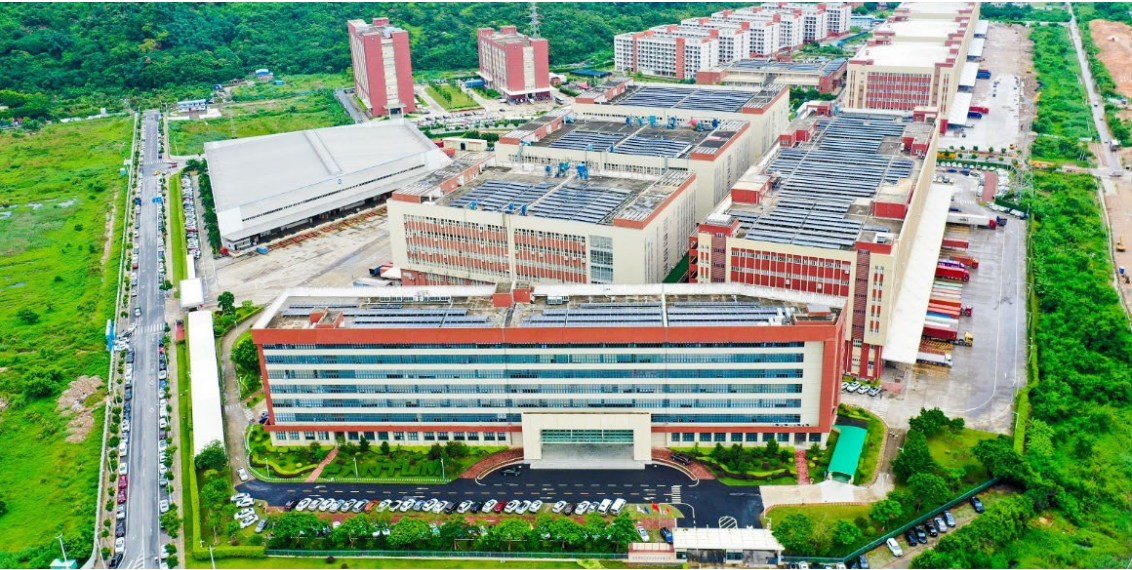
厂房楼顶光伏发电设备
