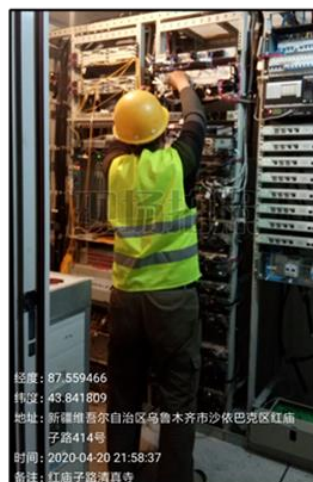
基站设备安装
