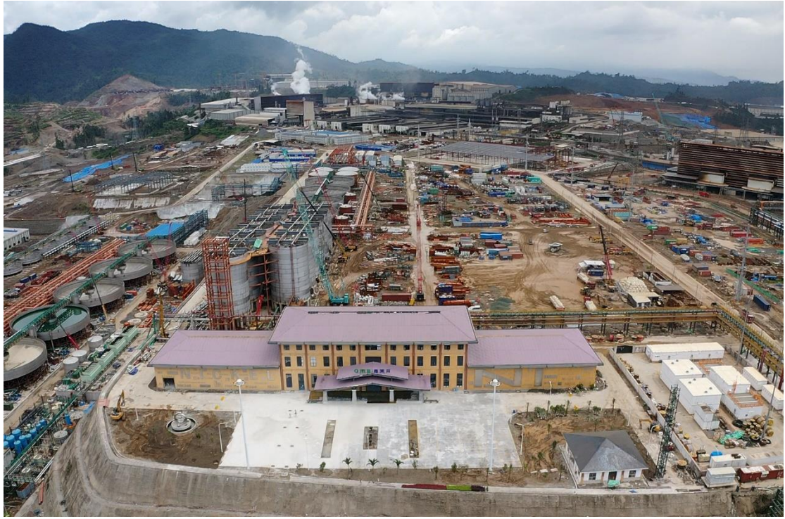
图 1：印尼青美邦镍资源项目现场
