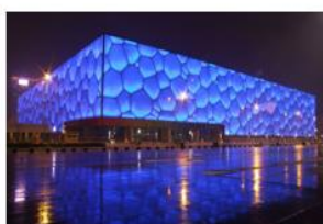
项目名称： 国家游泳中心（水立方） 选用科顺股份材料： 丙烯酸型高聚物水泥弹性防水涂料
