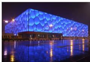
项目名称: 国家游泳中心（水立方） 选用科顺股份材料: 丙烯酸型高聚物水泥弹性防水涂料
