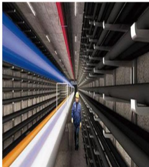
江北综合管廊基坑监测
