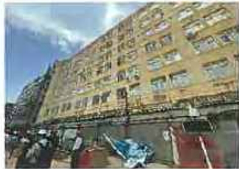
东侧裕华大厦
