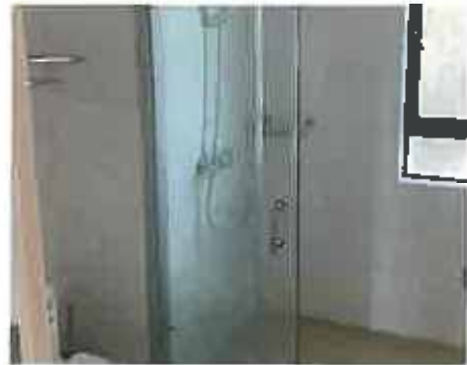
估价对象-三房两厅-卫生间
