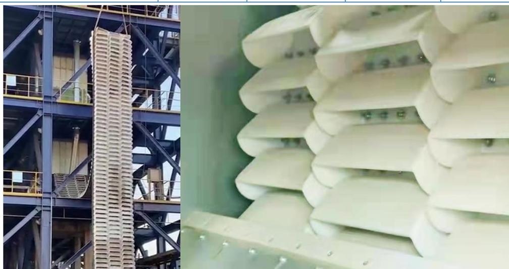
注：山东日照岚山港散粮输送筒仓用斗式提升机组装（左图）及内部结构图（右图）
