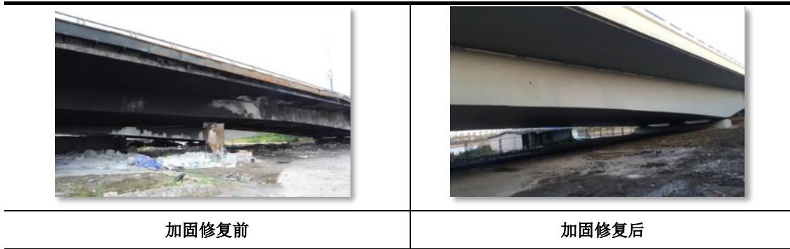
G312 国道新武宜运河桥火灾后维修加固工程
