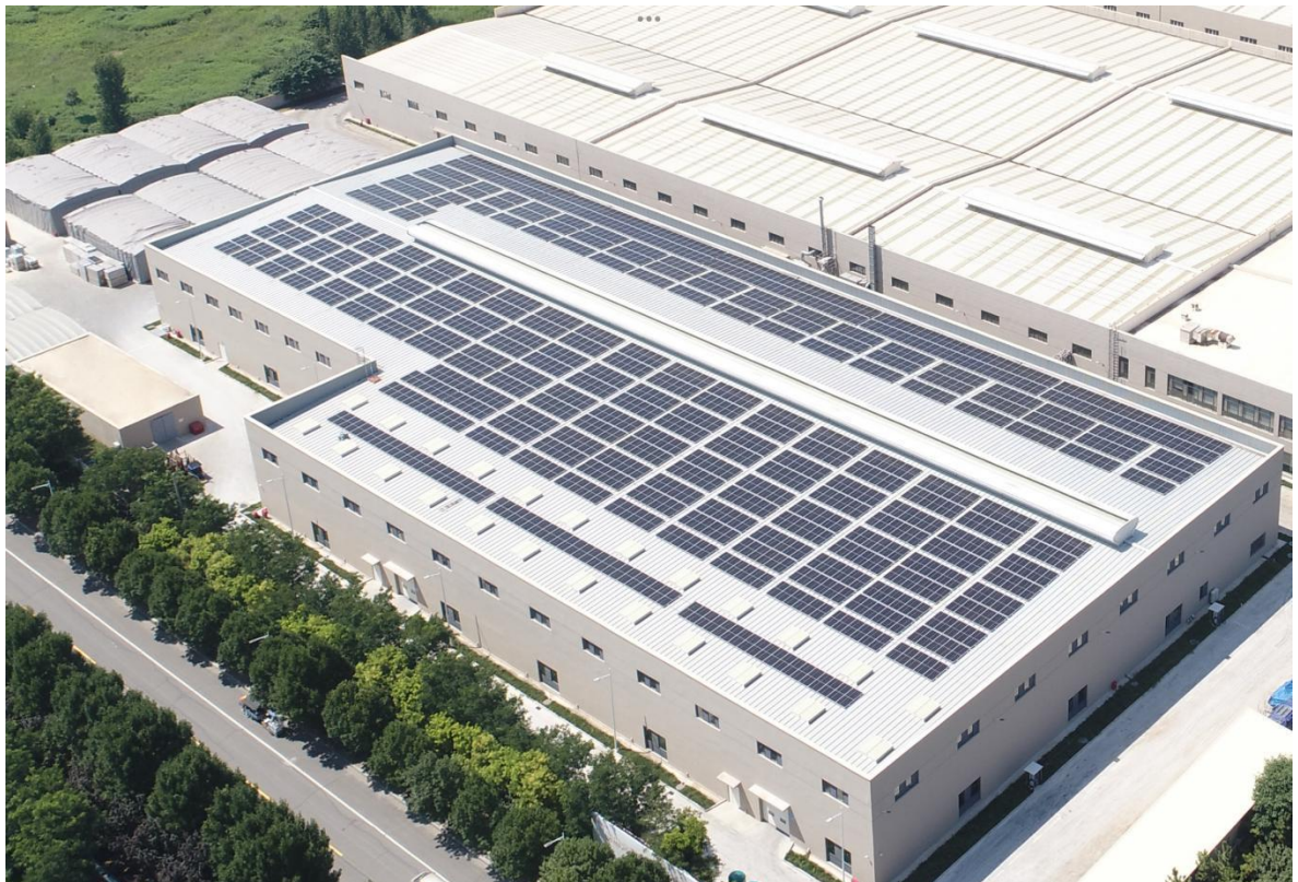
图—公司屋顶光伏项目
