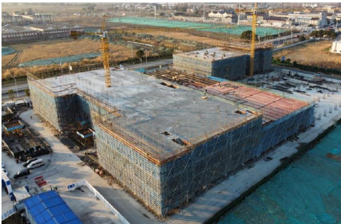
公司新工厂项目如期开工建设中
