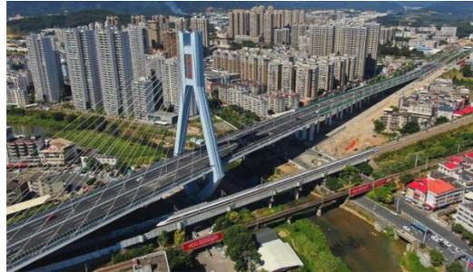
图 6：NCC 桥梁钢结构应用于跨线桥
