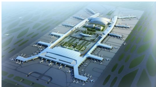
广州白云国际机场 T2 航站楼 (全国绿色建筑创新奖一等奖)
