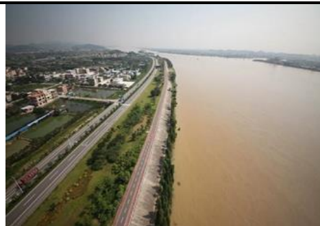
江门市江新联围干堤加固工程 (中国优质水利工程奖)
