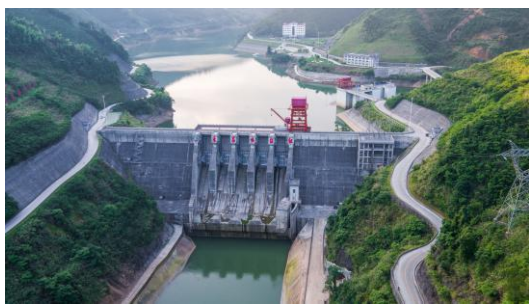
乐昌峡水利枢纽拦河坝工程 (广东优质水利工程奖)
