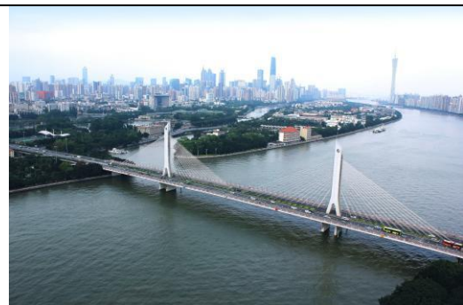
广州海印桥 (中国建设工程鲁班奖)
