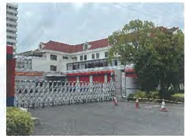
东至松江区新桥消防救援站
