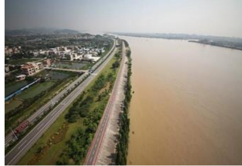
江门市江新联围干堤加固工程 (中国优质水利工程奖)
