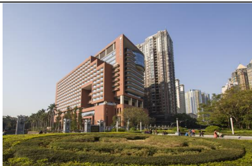
中山大学科技文化交流中心装修工程 (中国建筑工程装饰奖)
