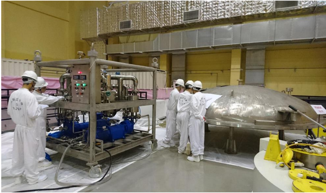
核能装置安装
