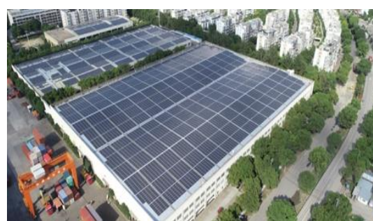
宁波金田铜业 BIPV20MW 光伏电站
