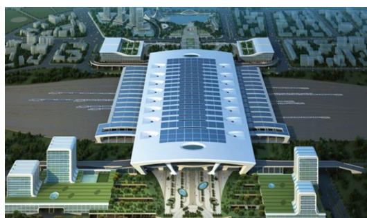
杭州东站 10MW 光伏电站
