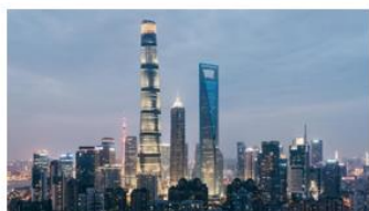
上海中心大厦 工程监理、绿色建筑咨询、工程检测、BIM咨询、能效测评、钢结构涂装
