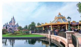
上海国际旅游度假区 地基基础、钢结构、市政道路、室内环境、防火等检测，职业卫生、空调通风卫生学评价
