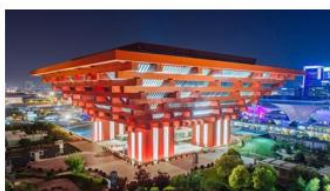
上海世博会中国馆 建设与改建工程监理、结构数值分析模型、幕墙检测、桩基检测、改建房屋抗震鉴定
