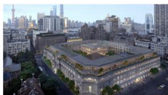
上海市老市政府大楼 文物建筑勘察和数字化保护技术服务
