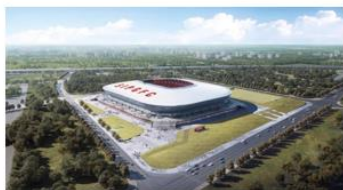
浦东足球场 工程监理、结构健康监测、工程检测、能效测评
