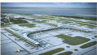
浦东国际机场 工程监理、工程与材料检测、工程监测、BIM运维、环境影响评价
