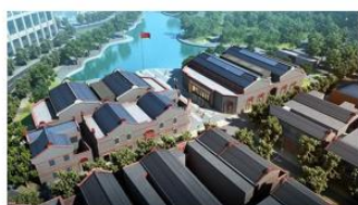
中共一大纪念馆 代建管理、工程检测、环境评估
