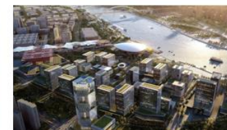
新开发银行总部大楼 工程监理、绿色建筑咨询、LEED咨询、健康建筑咨询、BIM咨询、工程检测
