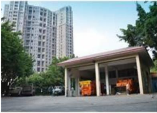
垃圾压缩中转站全貌
