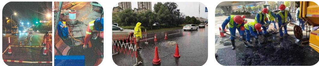
华尔兹泵站DN400出站压力管破损，导致污水漫溢路面，随后积极与周边小区沟通，迅速展开抢修工作，避免了污水漫溢的社会影响，同时重修小区进出路面，满足了周边居民的正常通行要求。
